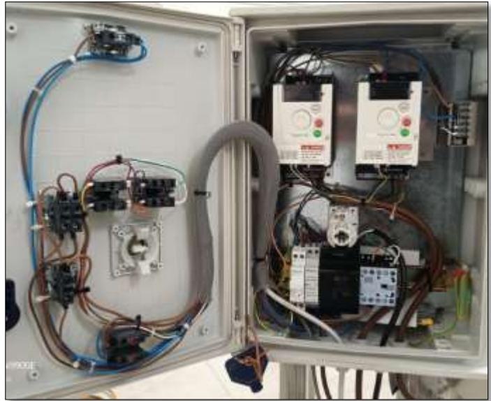
Fig. 81 – Quadro gestione sistema di visione e scarto - Particolare. Fig. 82 – Quadro comando, di potenza e bassa tensione - Particolare.
